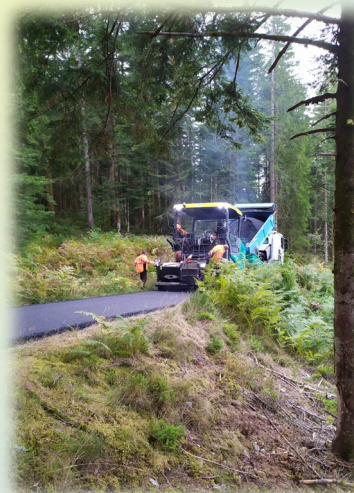
Réfection de la chaussée route forestière des Rosiers
