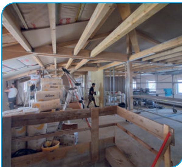
Pose des premières cloisons futures des chambres d'hébergement
