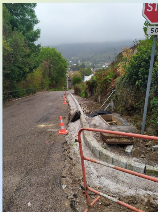
Rue du Quartier : pose du macadam semaine prochaine
