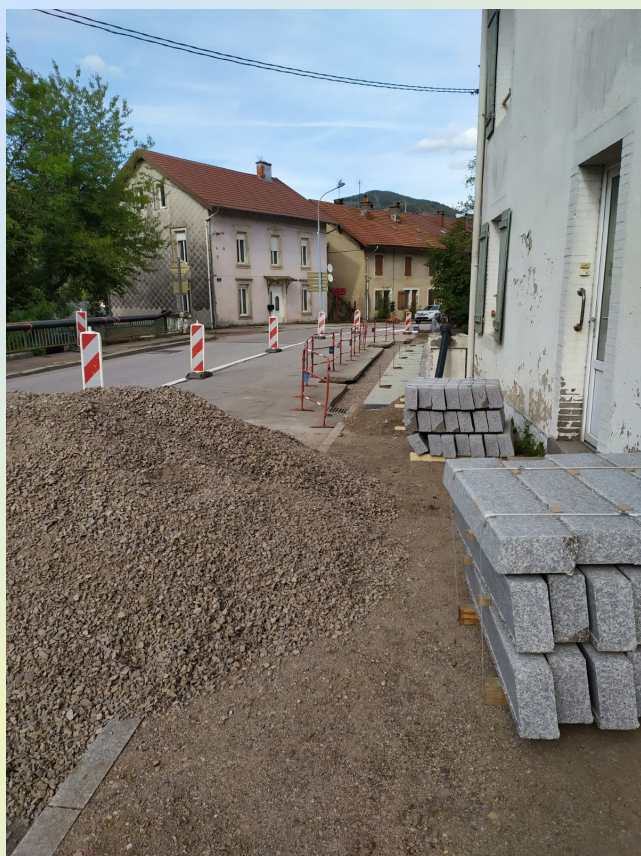
Pont des Barranges : renforcement de l'ouvrage sur un côté du trottoir
