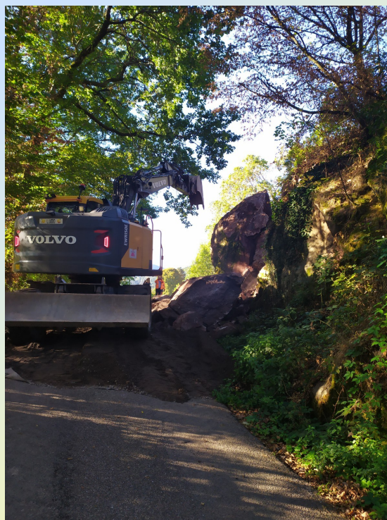
Route des Suais : travaux de sécurisation d'un virage
