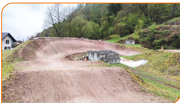
Avant la pose des pavés
