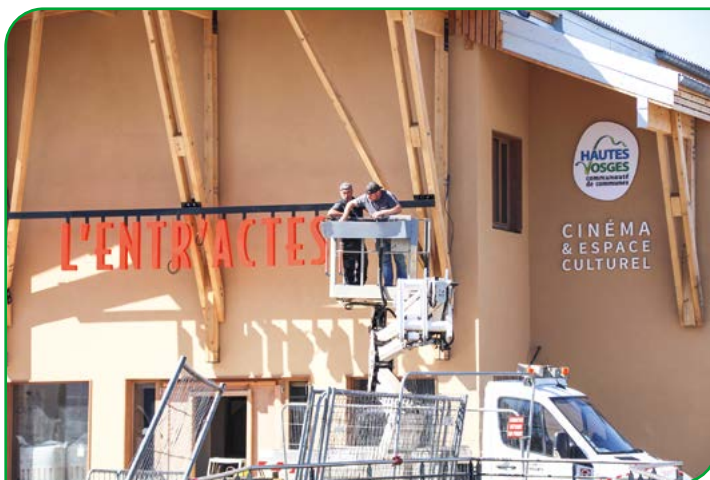
Pose de l'enseigne du cinéma
