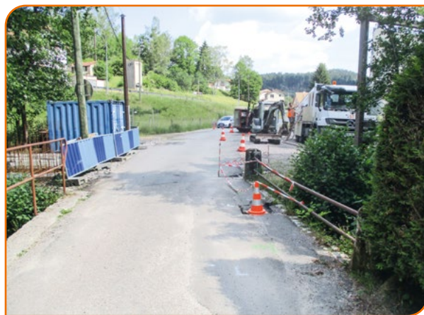
Pont de Bonnegoutte
