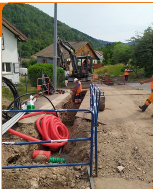
Enfouissement des câbles
