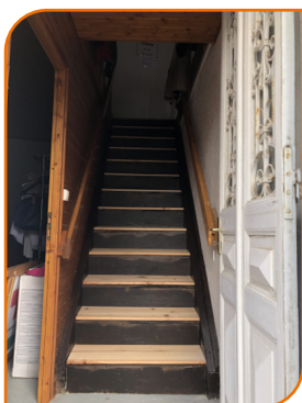
Pose de main courante et renforcement des marches
