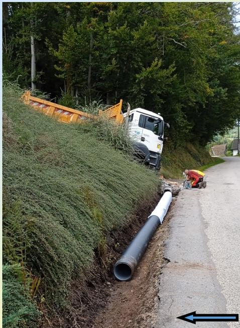
**Travaux de fossé au début de la route du Droit** : le fossé devenant dangereux, pour les voitures, un tuyau de 50 m a été positionné puis recouvert de cailloux afin de rendre l'accotement plus sécuritaire et reprise des ouvrages béton à l'entrée et à la sortie de ce chantier, réalisé en interne.
