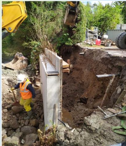
Début avril, l'entreprise BONINI a repris les travaux de terrassement, coulage de béton de la semelle et de la culée. Pour quelques semaines, la route est barrée à hauteur du Jardin de Bonnegoutte. Les accès se font sur la partie haute en direction du Ménil.
