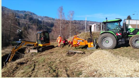
**Nettoyage et curage du canal du Faing en collaboration avec l'association de Pêche AAPPMA :** arbres et branchages transformés en paillis à l'aide du broyeur communal. Ce terreau sera le bienvenu pour alimenter nos parterres au printemps.
